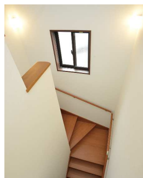
▲壁付けのコーナー照明がお洒落な階段室。廻り階段部分はバリアフリー性を考慮して構成しました。
