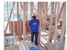
適材適所に構造金物が正しく取り付けられているか検査
