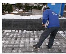
鉄筋の配置・寸法・組み方等正しく配筋されているか検査
