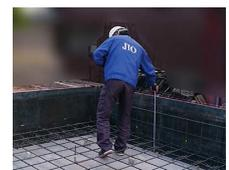
鉄筋の配置・寸法・組み方等正しく配筋されているか検査
